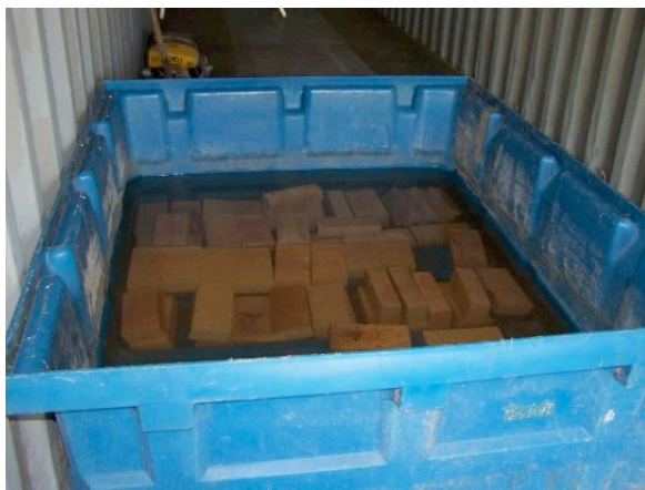
Trempe des briques. Prévoir une journée de trempage. Amener le bac assez près de la zone de travail, à cause du poids.
