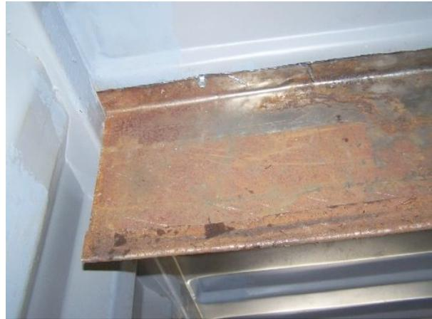
Cette plaque ne sert pas réellement à bloquer les fumées car en quelques secondes, celles-ci passent sous la plaque. Par contre, si vous mettez une plaque de 30cm par exemple, cela gêne la progression des flammes et perturbe donc le déroulement pédagogique. C'est pour cela qu'une plaque de 10 à 15cm est suffisante (la plaque sur la photo ci-dessus est un peu trop grande).
