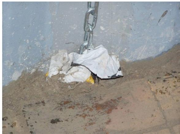
*Protection des anneaux de fixation au sol. L'idéal est d'y fixer les chaînes puis de protéger avec du papier.*
