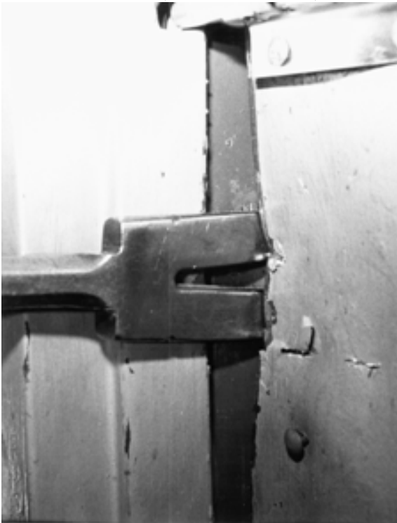
Extrémité de la FOURCHE verrouillée dans le cadre
